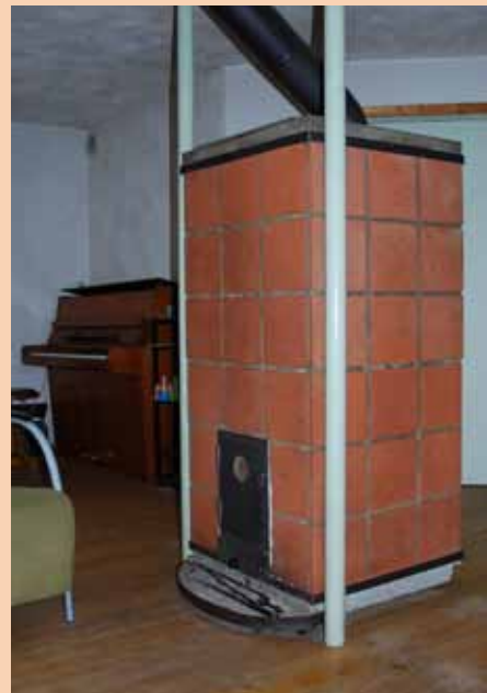
Houtgestookte Fin-oven met ongeglazuurde Kerkdrieltegels.
