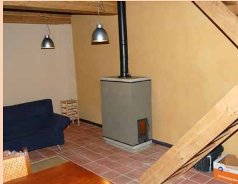
Een van een lemen stuclaag voorziene standaard-tegelkachel. Desgewenst kunt u uw kachel na het bouwen thuis op deze manier afwerken. (foto: Kees en Gemma Schalkwijk)
